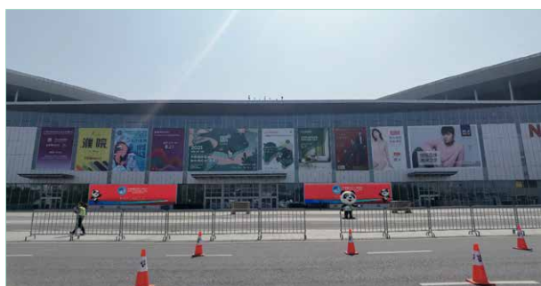
B18B 玻璃墙贴 – 北馆外幕墙广告
